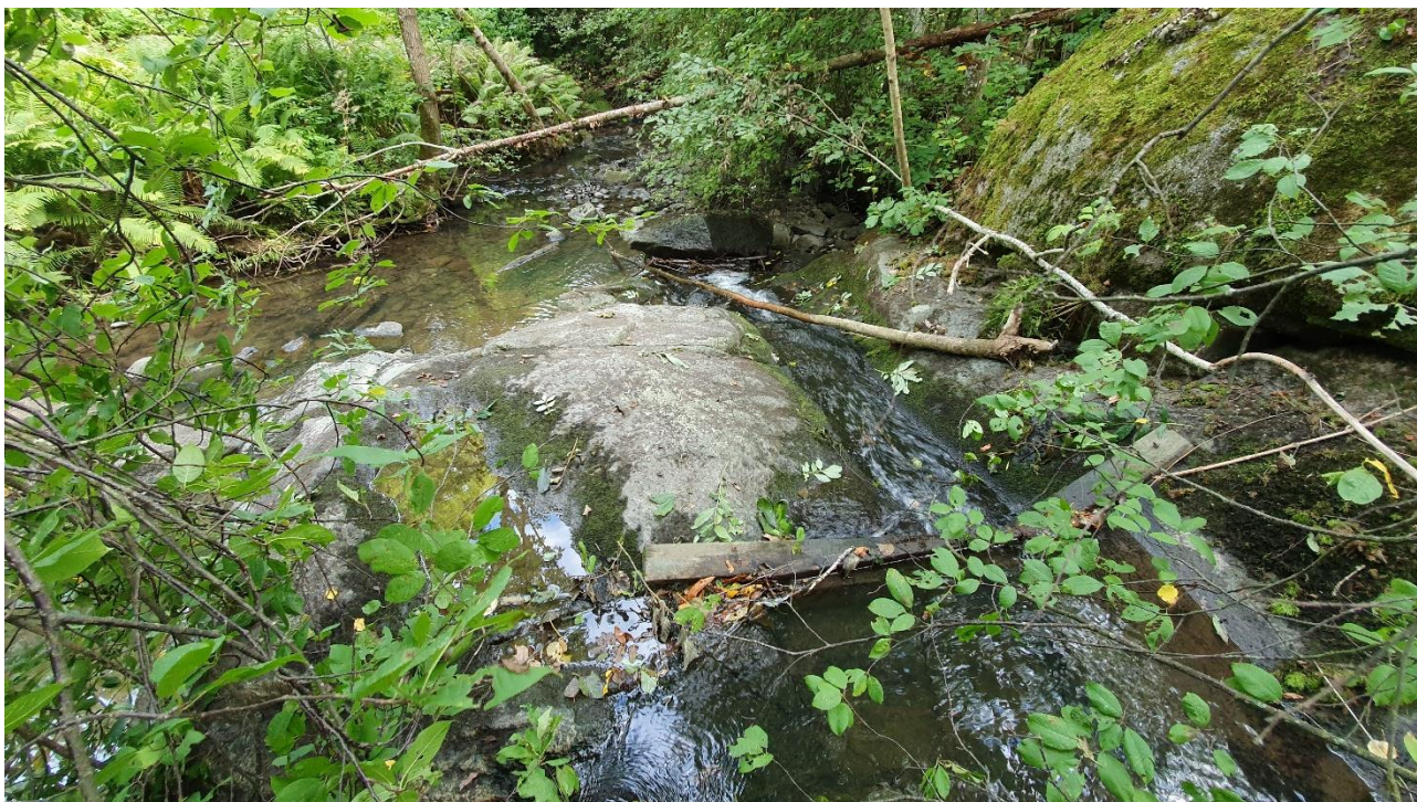
Figur 5. Terskel av treplanker før hovedfallet ned i elva nedstøms fjellet. Noe vann går også ut i en liten renne til venstre (ikke synlig – se figur 3). Foto: 30.08.2020.
