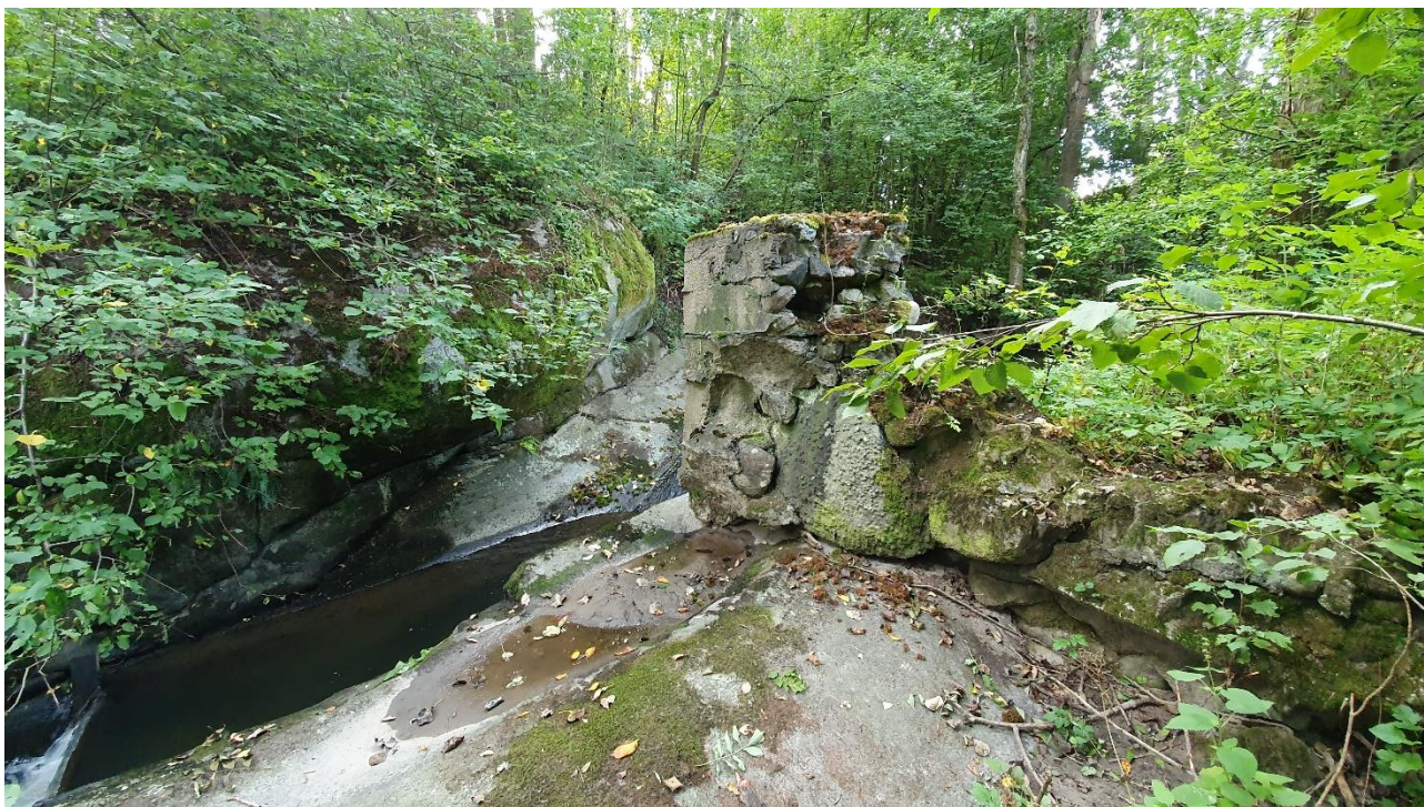
Figur 2. Søndre del av gammel dam. Bekkeløpet går i dag i isskuringsrenne mellom gammel dag og fjellet mot syd. Foto: 30.08.2020.
