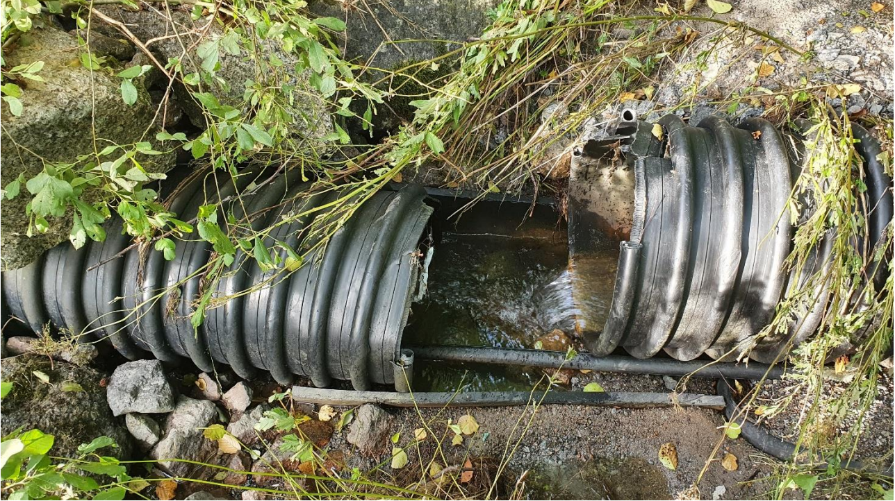
Figur 11. Rørsituasjon i punkt R1. Rør fra kum K1 kommer inn fra høyre. Rør videre mot venstre renner under veien og munner ut i R2 (se annen figur). Foto: 27.08.2020.
