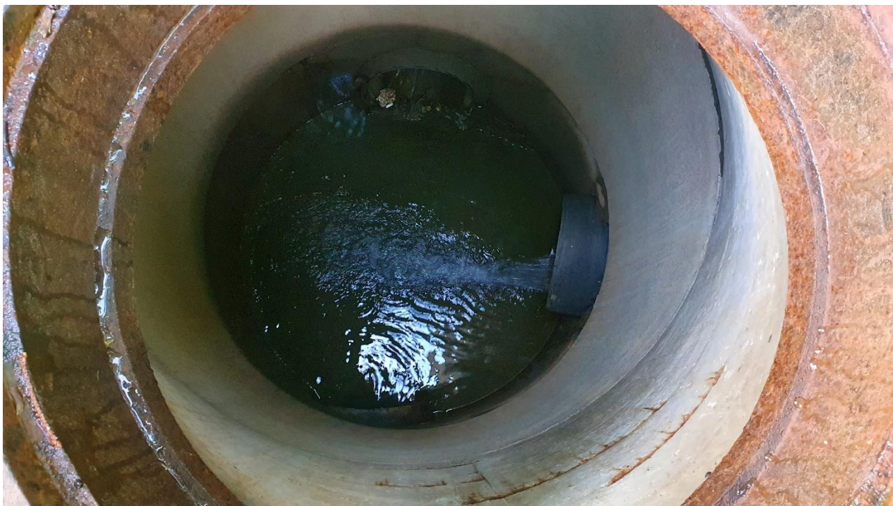
Figur 13. Kum K1. Rør fra kum K2 kommer inn fra høyre i bildet. Rør fra kum K3 kommer inn i bunnen av bildet (lite synlig). Rør til R1 renner ut i øvre kant av bildet. Dyp ned til rør vurdert til 2,5-3 meter. Foto: 27.08.2020.
