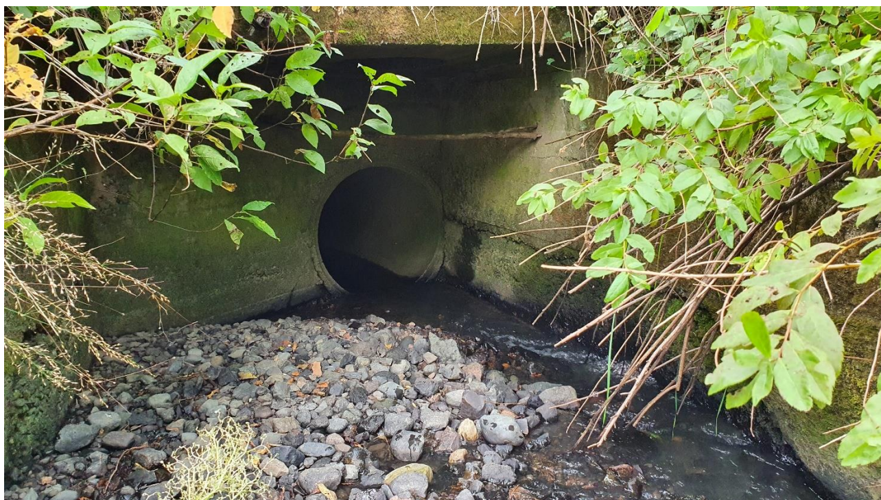
Figur 3. Innløpsområdet. Det er støpte betongkanter og et lite betongtak over innløpet.
