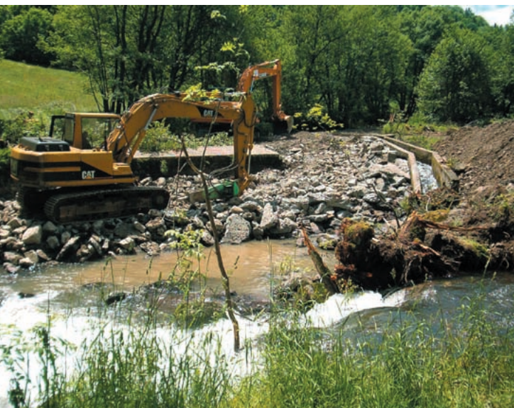
L'arasement du seuil de Stalapos en juin 2008, durant la phase de travaux. Le cours d'eau est dévié pour permettre la mise à sec du seuil et de la retenue.
