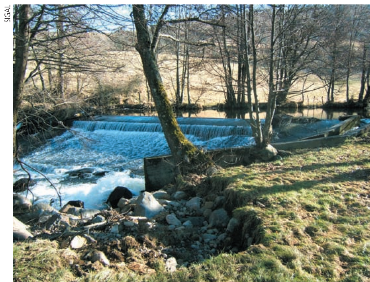
Point de vue sur le seuil avant (à droite) et après arasement (ci-dessous, en novembre 2009). Le site est en partie revégétalisé, le lit mineur est diversifié.
