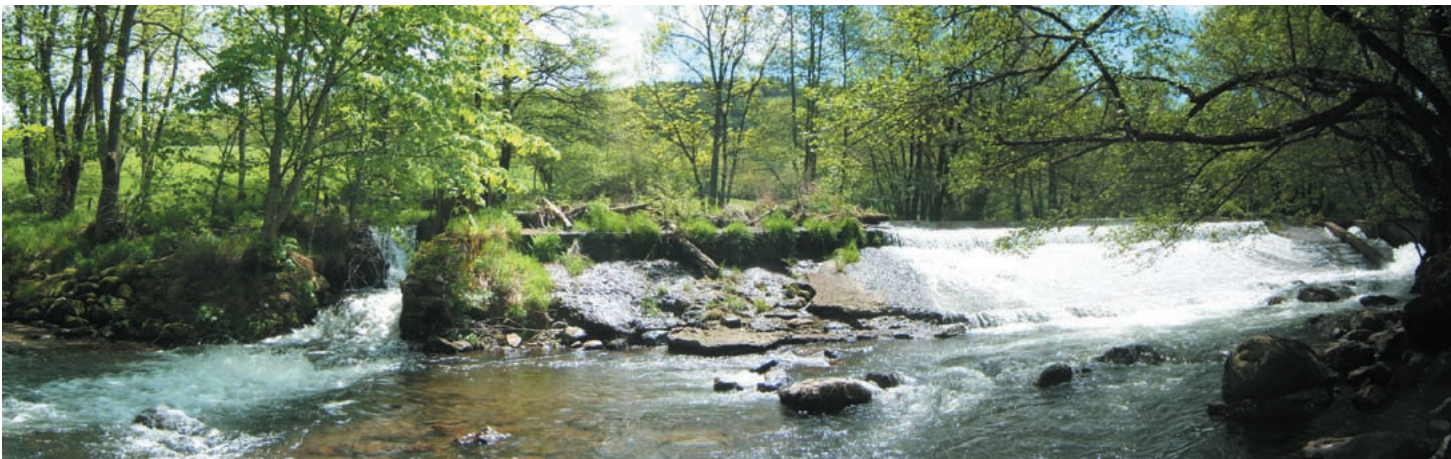
Le seuil de Stalapos en janvier 2008, avant les travaux d'arasement.
