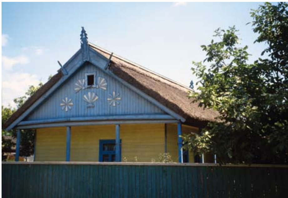
Fig. 80: Traditional house with thatched roof (Chilia Veche) Casă tradițională cu acoperiș de stuf (Chilia Veche)
