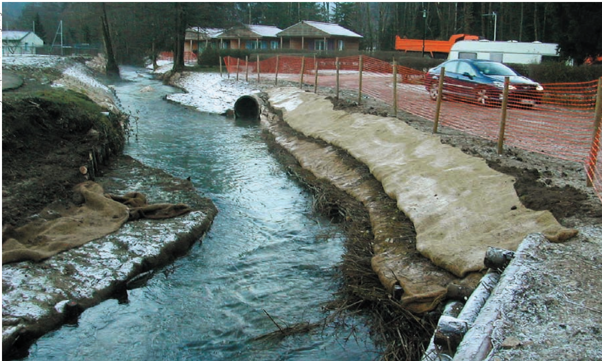
Le Merloz en décembre 2008 : recréation d'un chenal d'étiage sinueux par la pose de banquettes.
