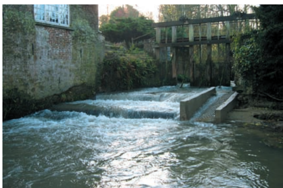
Le vannage de Wavrans-sur-Ternoise après aménagement : ouverture de vannes et passe à poissons.
