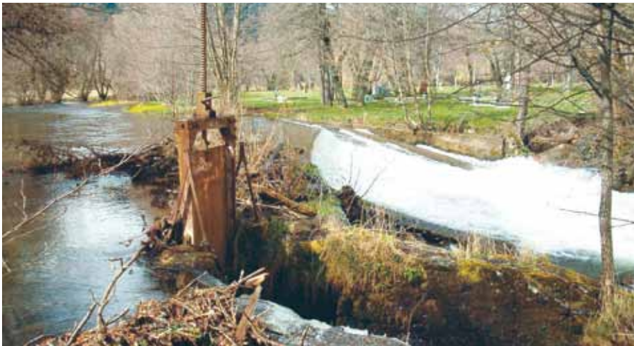
Le site de Stalapos avant les travaux d'arasement.
