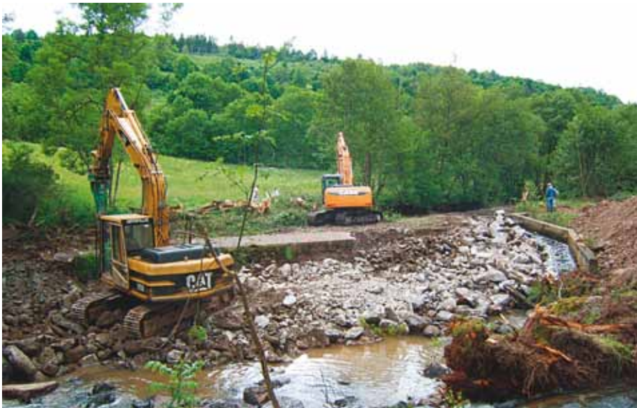
Arasement du seuil au printemps 2008.
