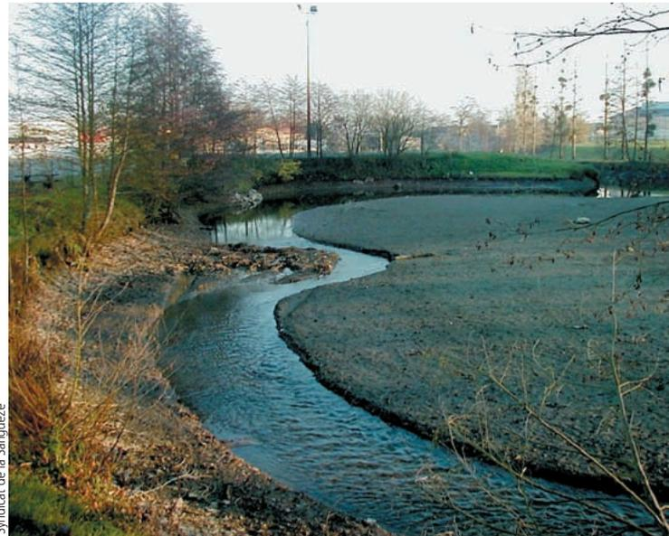
La cuvette de la retenue, en 2004, après les travaux d'abaissement de l'ouvrage de retenue. Le cours d'eau retrouve naturellement un chenal d'écoulement sinueux.
